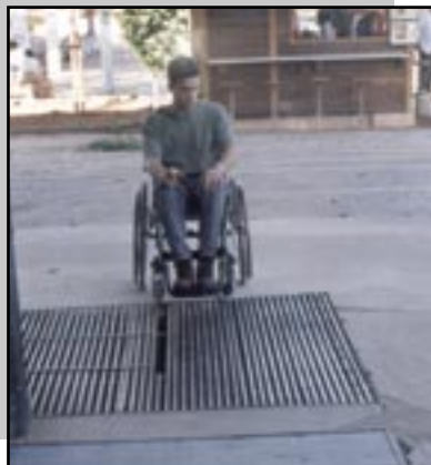
Figura 005 - Grelha de proteção no piso danificada impedindo a circulação de cadeira de rodas.
