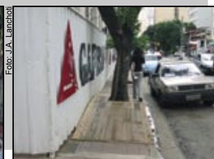
Figura 231 – Com o andaime da obra, o passeio público foi reduzido e a única passagem tem um tablado com uma árvore no meio. Embora todo o cuidado em oferecer uma rampa na travessia, a solução não é adequada, segura ou firme para uma pessoa em cadeira de rodas, idosos, muletantes etc.
