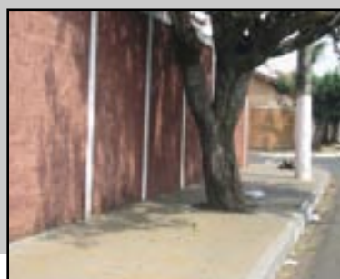
Figura 122 - Vegetação implantada de forma equivocada, resultando em inaccessibilidade na circulação de pessoas.
