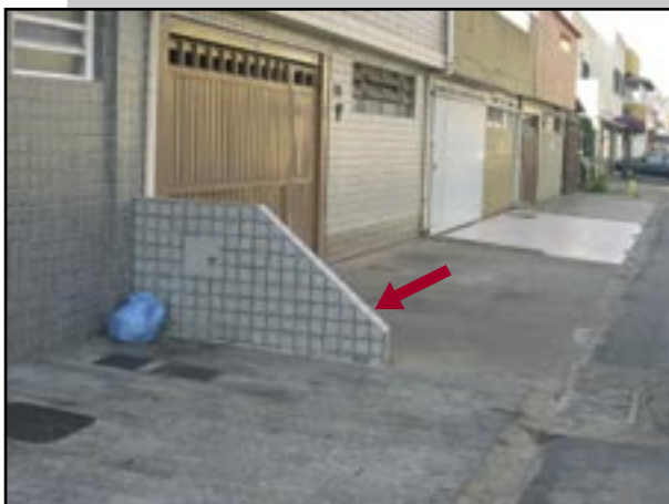
Figura 238 – Obstrução na livre circulação da calçada provocada pela vontade individual do proprietário.
