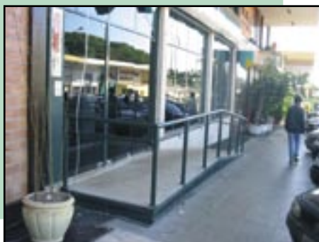
Figura 245 – A implantação de rampas de acesso sobre a calçada não corresponde uma solução ideal, porém uma adequação possível quando se tem calçadas largas, edificações coladas nas diversas laterais e comprovada impossibilidade da rampa adentrar à edificação.
