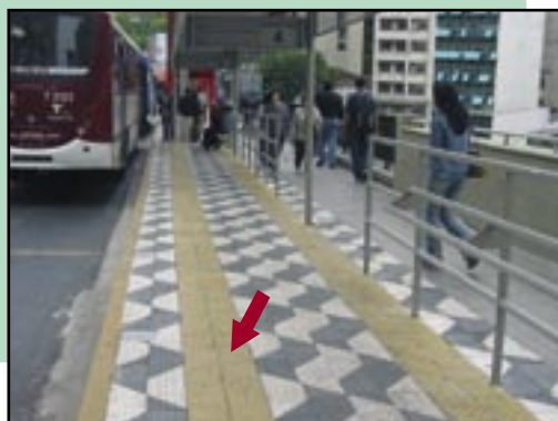
Figura 205 – Parada de transporte coletivo com faixa de orientação com textura e cor diferenciada do restante do piso, facilitando a circulação e o acesso de pessoas com deficiência visual aos veículos.
