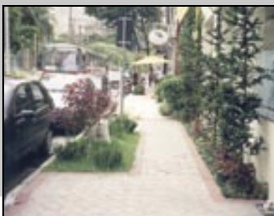
Figura 121 - Paisagismo na calçada ocasionando estreitamento do passeio público.
