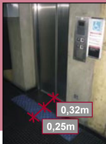
Figuras 267 e 268 – Junto a portas de elevadores, início e término de escadas e rampas deverá haver a indicação de mudança de plano com o piso tátil, em largura de 0,25m a 0,60m, afastados 0,32m.
