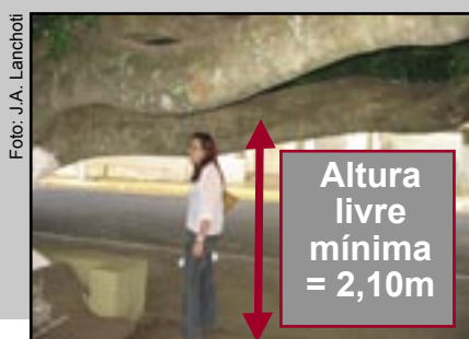
Figura 229 – Vegetação com galhos abaixo de 2,10m de altura dificultando a circulação de pessoas.
