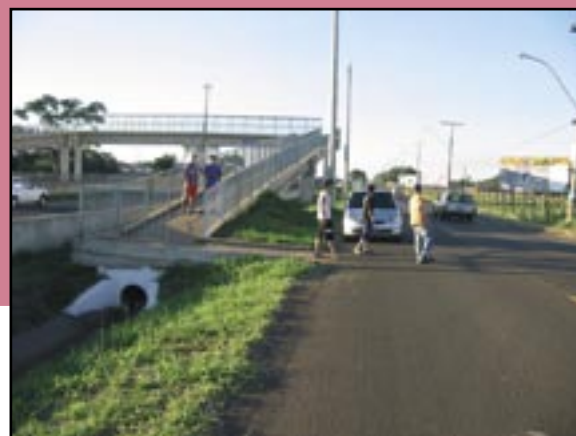
Figura 302 – MAU EXEMPLO de rampa que termina sobre pista de veículo, colocando em risco a segurança de quem a utiliza.
