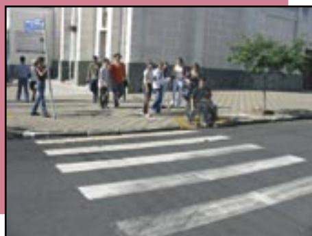
Figura 290 - Pessoa em cadeira de rodas atravessando a pista de veículos através do conjunto faixa-rampa. Destaca-se que a rampa foi locada fora da faixa de travessia e isso não deve acontecer.
