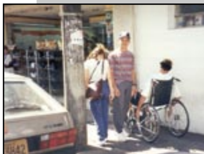
Figura 120 - Passeio público inadequado para a circulação de 2 pessoas em cadeiras de rodas ou 1 pessoa em cadeira de rodas e duas pessoas. A locação do mobiliário pode prejudicar os movimentos.
