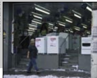
Figura 152 – Loja de grande rede comercial recém-inaugurada, cujos acessos são todos por intermédio de escadas.
