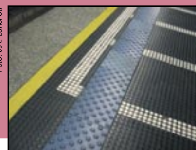
Figura 270 e 271 – Quando da existência de longos planos em desníveis como palcos e plataforma de embarque e desembarque deverá haver uma faixa de piso tátil com largura entre 0,25m e 0,60m, instalada a no mínimo 0,50m de distância.
