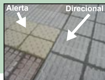
Figura 262 – Aplicação de pisos táteis de alerta e direcional em um mesmo projeto, demonstrando a preocupação com a questão da acessibilidade.
