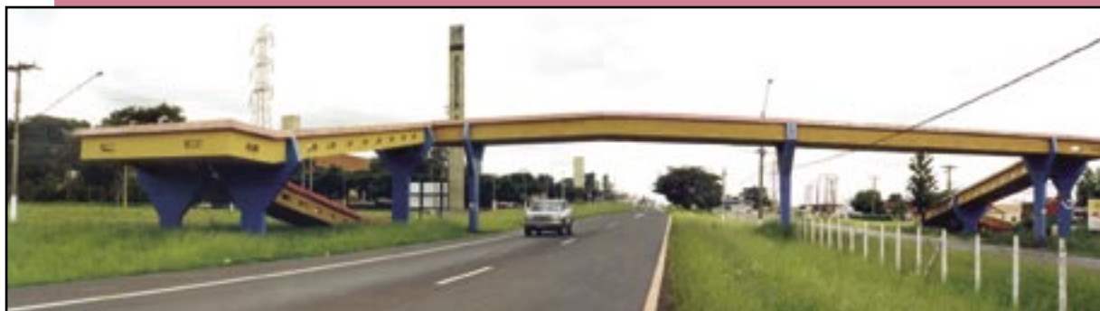
Figuras 298 – Travessia de pista expressa em área urbana por intermédio de passarela acessada por rampa. Sua inclinação deve respeitar o valor máximo de 8,33% com patamares de descanso de acordo com a fórmula apresentada [ i=(h \times 100/c) ] – ABNT NBR 9050:2004.
