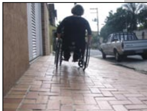
Figura 051 – A inclinação transversal da calçada obriga com que a usuária da cadeira de rodas faça um grande esforço físico para se manter na direção de seu percurso.
