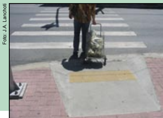
Figura 165 – Rampa de acesso à calçada construída com o conceito da acessibilidade na cidade de São Paulo, com inclinação correta e piso de alerta em sua base.
