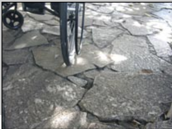
Figura 248 – A dificuldade de locomoção é provocada pela irregularidade do piso que, por sua vez, é inadequado e mal aplicado como acabamento de área pública de circulação.
