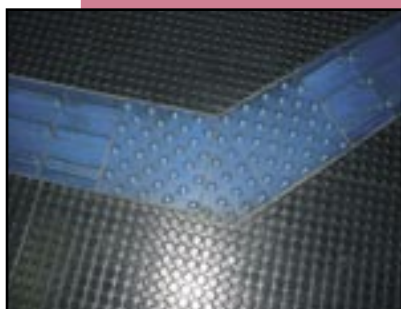
Figura 269 – Para as mudanças de direção do piso direcional , a junção entre estas duas faixas direcionais deverá ser demarcada com piso de alerta, que orienta esta mudança.
