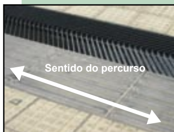
Figura 260 – Aplicação do modelo de piso tátil direcional , estabelecido na NBR 9050:2004 próximo à grelha de água pluvial que é oblíqua em relação ao sentido da circulação da pessoa. O piso direcional orienta o sentido do percurso e está instalado próximo à grelha.
