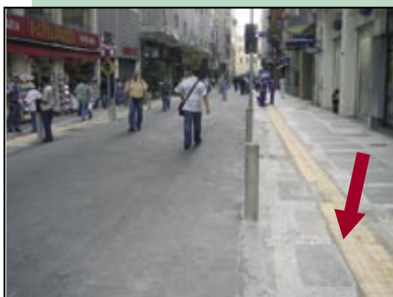
Figura 099 – Área de circulação exclusiva de pessoas, porém com faixa para eventual passagem de veículos. Destaca-se o piso tátil indicando uma rota acessível.
