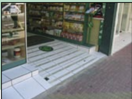
Figura 244 – Acesso a estabelecimento comercial com rampa suave. Lixas foram colocadas para aumentar a segurança contra pisos escorregadios. Este é o único acesso à loja, o que demonstra que todos utilizam o mesmo acesso. Isso é positivo.
