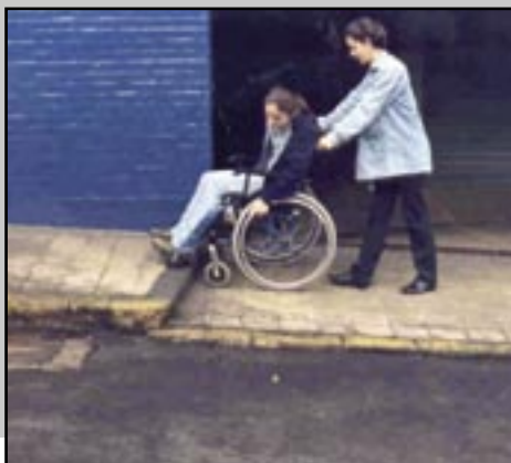
Figura 004 - Desnível em calçada impedindo a circulação de cadeira de rodas.
