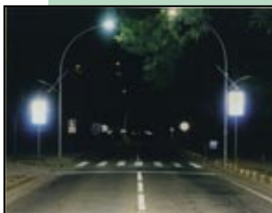
Figura 156 – Travessia iluminada com faixa de travessia em toda a largura.
