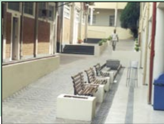
Figura 129 - Escola adaptada para atender alunos com mobilidade reduzida. Por se tratar de edificação antiga teve que receber intervenção dentro das possibilidades técnicas.
