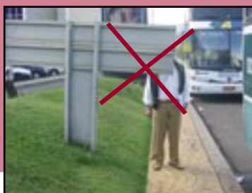
Figura 191 – Placa de indicação de logradouro com partes projetadas sobre o passeio público e que não seriam detectadas por pessoas com deficiência visual (ou pessoas desatentas), podendo ocorrer acidentes.
