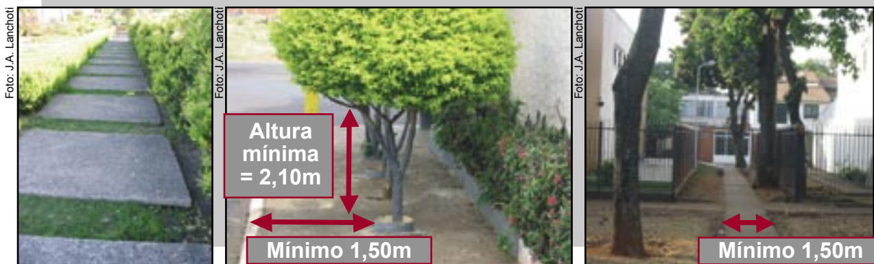
Figura 232 —Piso inadequado para a mobilidade acessível por estar descontínuo.
