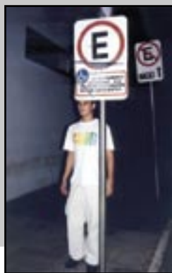
Figura 125 - Placa de trânsito muito baixa, podendo provocar acidentes.
