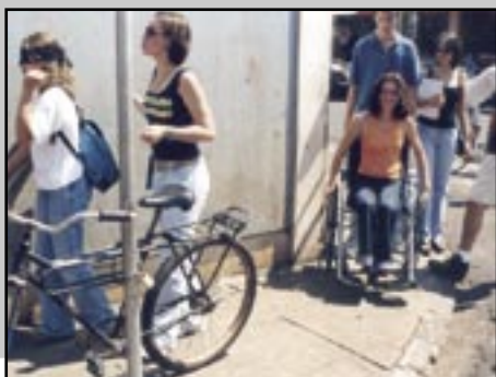
Figura 055 – A largura reduzida da calçada impede a circulação da cadeira de rodas.
