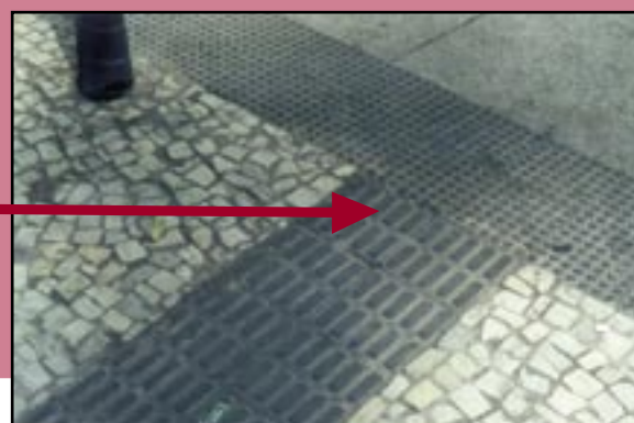
Figuras 272 e 273 – Para os rebaixamentos de calçadas ou elevação da faixa de travessia, com o objetivo de travessia, em que houver a indicação do piso direcional, este deve encontrar uma faixa de piso de alerta.
