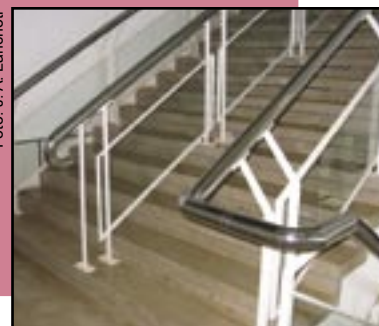
Figura 330 – Corrimão contínuo com curvas arredondadas suavizando o correr das mãos, o que aumenta a segurança e o equilíbrio dos usuários, principalmente em casos de fuga.
